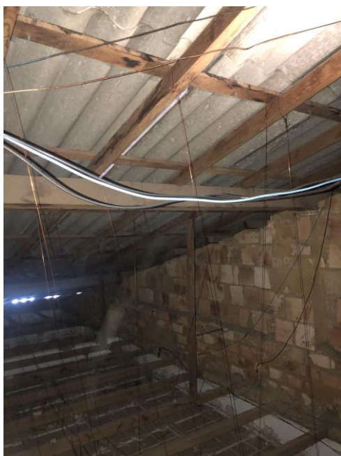
Foto 19 e 20: Abertura entre as telhas causando infiltração no gesso.
