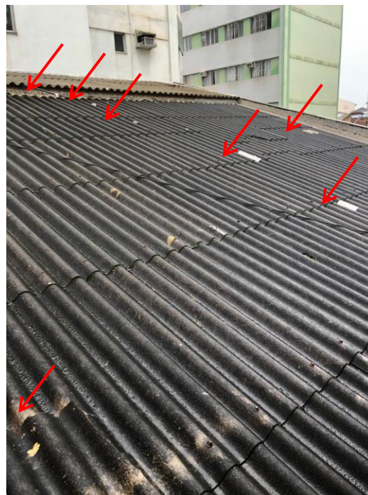
Foto 14 e 15: Remendos, telhas quebradas e fissuras nos rufos de vedação do telhado.
