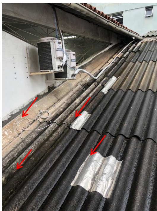
Foto 14 e 15: Remendos, telhas quebradas e fissuras nos rufos de vedação do telhado.
