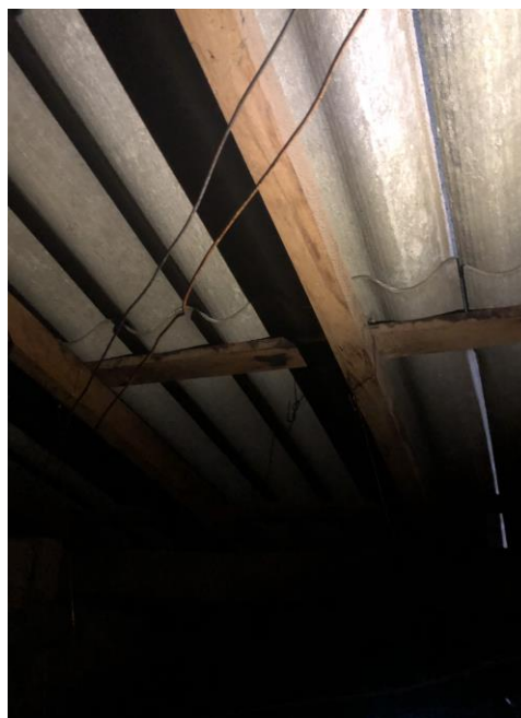
Foto 19 e 20: Abertura entre as telhas causando infiltração no gesso.
